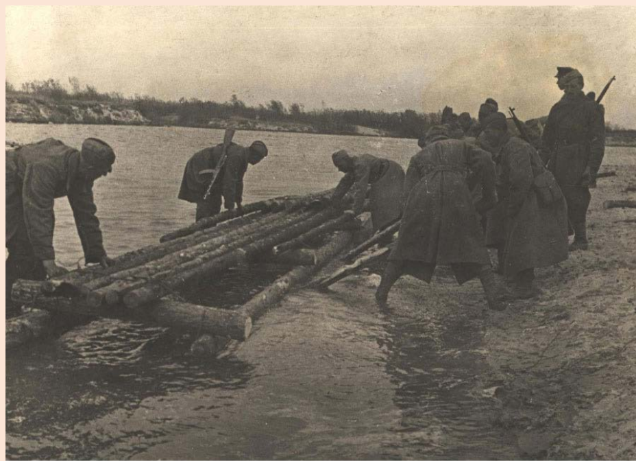
Бойцы сооружают мост через реку Сож
