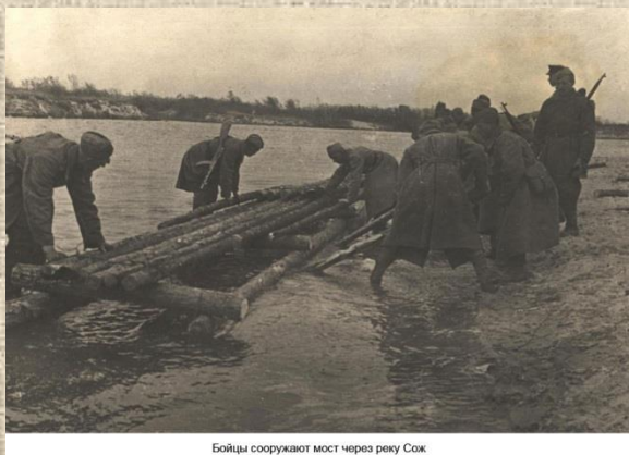
Бойцы сооружают мост через реку Сож.
