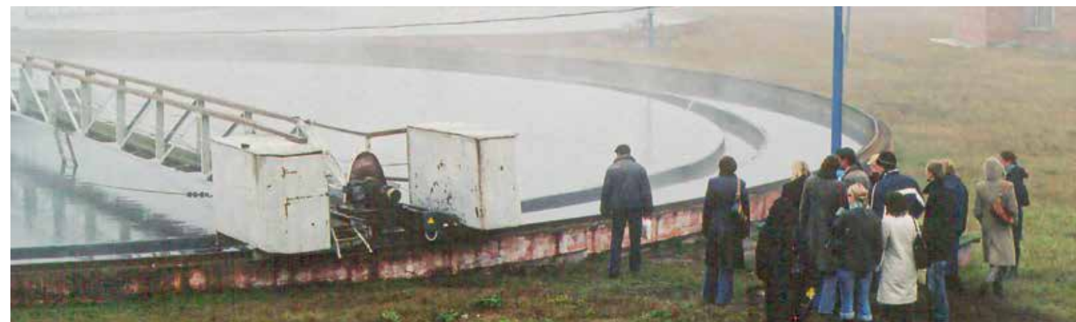
Студенты ГомГМУ первого выпуска специальности «Медико-профилактическое дело» на выездном практическом занятии по коммунальной гигиене. Станция очистки сточных вод в д. Уза, 2004 год
